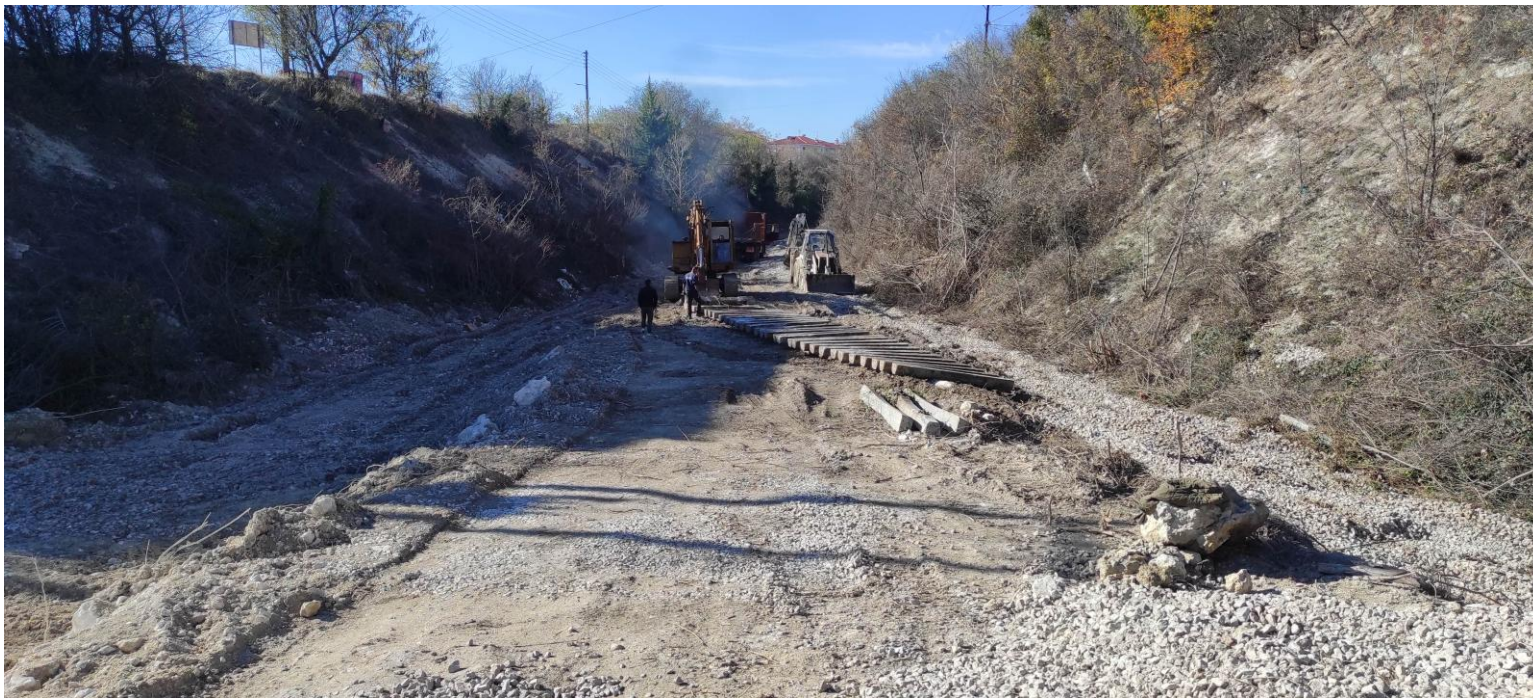
ΤΕΧΝΙΚΟ ΕΡΓΟ CUT & COVER (ΤΟΥΝΕΛ) ΣΤΗΝ ΠΕΡΙΟΧΗ ΤΟΥ ΣΙΔΗΡΟΔΡΟΜΙΚΟΥ ΣΤΑΘΜΟΥ ΚΟΖΑΝΗΣ
